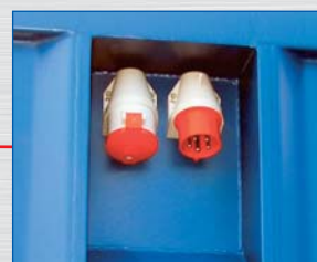
zapuštěné CEE přípojky
